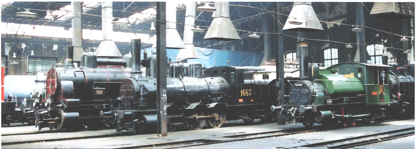
Blick ins Heizhaus | © Fotos: Rupert Gansterer
