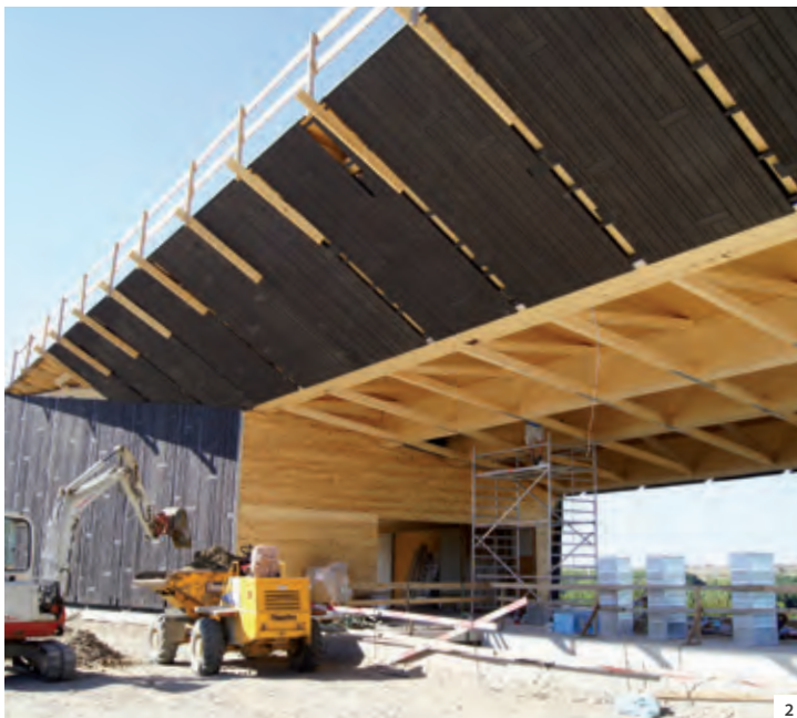
1-2 Das neue Eingangsgebäude des Museumsdorfs Niedersulz im Herbst 2011. Die Fassade ist eine Interpretation der bäuerlichen Holzscheunen. Die Struktur der Fichtenholzverplankung ist durch die Querhölzer gegeben. Mit diesen sogenannten „Opferhölzern“ werden die Stoßfugen gegen Witterungseinflüsse geschützt. © Museumsdorf Niedersulz
