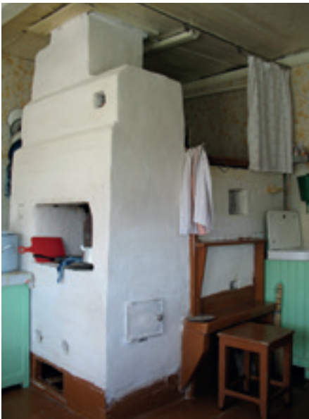
Das ist der Ofen der Familie Koschewnikow in Lebskoje, Archangelsker Gebiet. Vorn unten sieht man eine Öffnung, hier befinden sich Brotschieber und Geräte zum Rausholen der Kochtöpfe. Links gibt es noch Raum zwischen der Wand und dem Ofen, dort wird Hausrat aufbewahrt – Geschirr –, auch kleine Mengen von Mehl, Zucker, Getreide etc.
