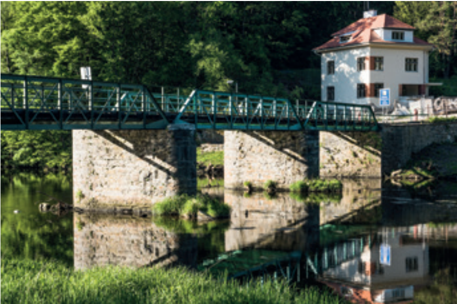
Bis zum Fall des Eisernen Vorhangs 1989 waren die Bodenbretter der Hardegger Brücke herausgerissen.
