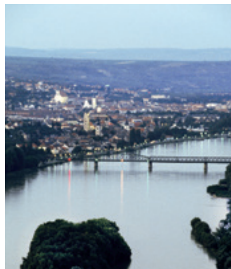
Brücke zwischen Stein (l.) und Mautern – auf der Steiner Seite die Bögen aus der k.u.k.-Zeit, auf der Mauterner Seite die Instandsetzung durch die Sowjetarmee 1945.
