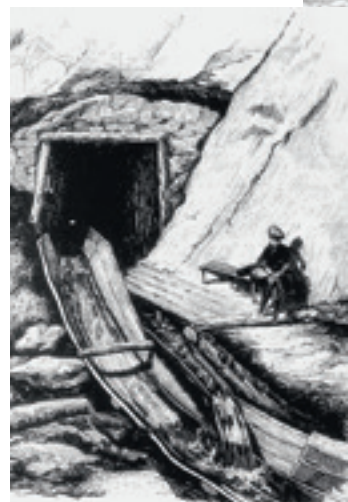
Aufzug zum 430 Meter langen Schwemmtunnel am Sattel des Gscheidls.
