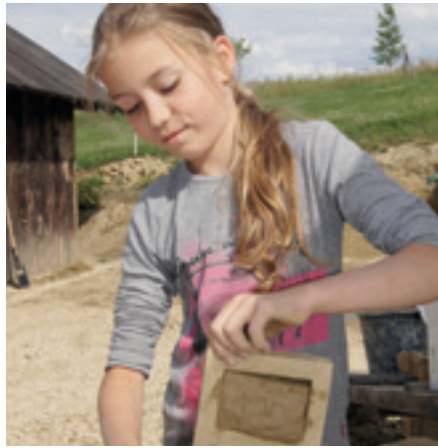
Lehmziegelschlagen auf der Lehmbaustelle.
