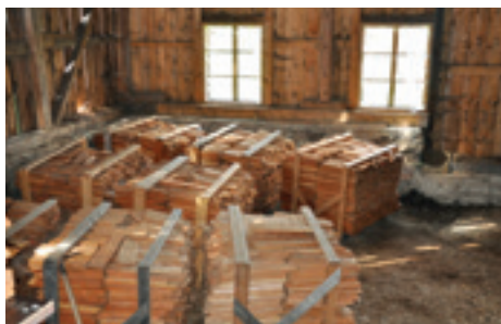
Schindeln – bereit zur Montage.
